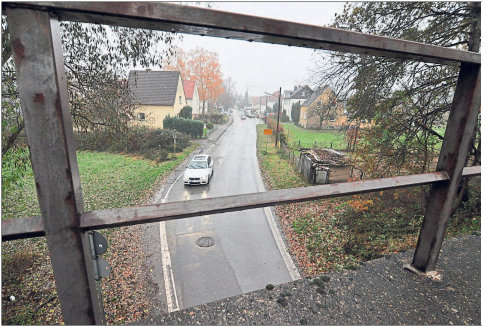
Der Blick vom Bahndamm auf die Warendorfer Straße. Wo das Auto fährt, spannt sich nach den Plänen von Straßenbau NRW bald die B 61 neu über die kleine Straße. Hier liegen die Häuser besonders nah
